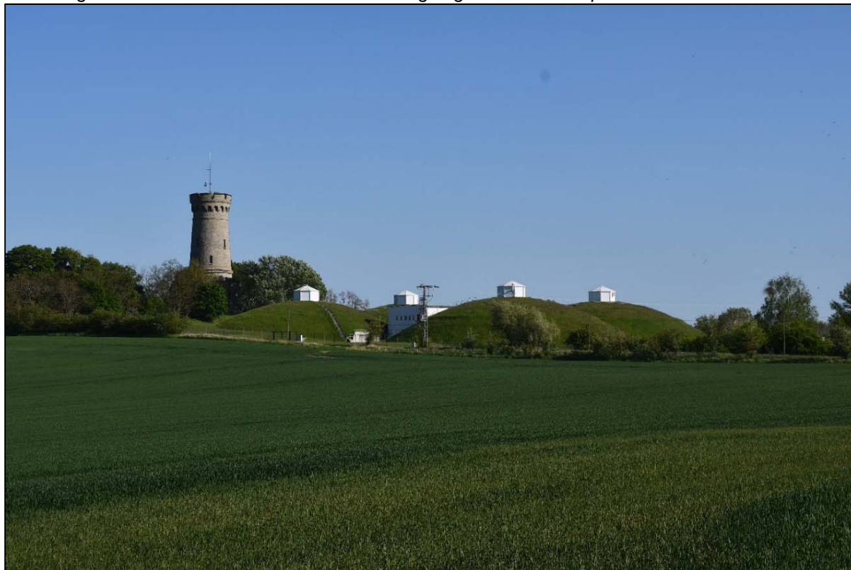
Abbildung 3: Blick auf den Bismarkturm mit vorgelagertem Wasserspeicher
