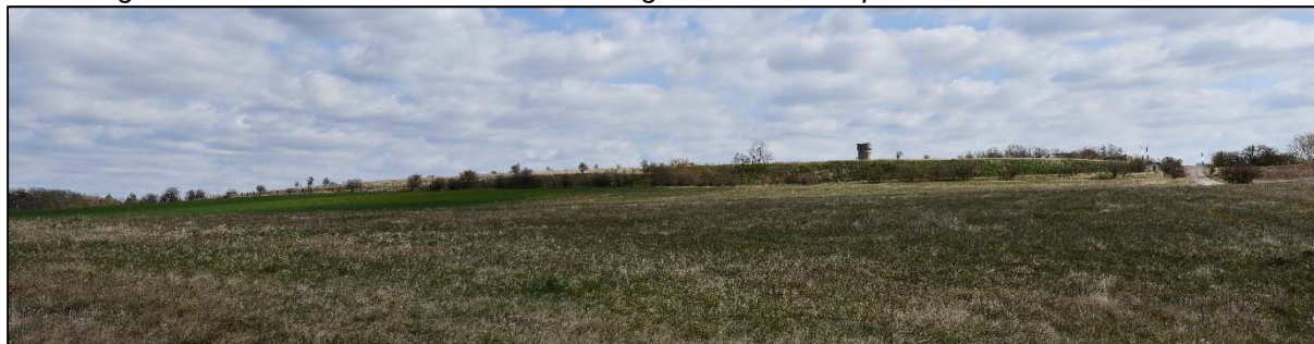
Abbildung 4: Blick auf den westlichen Böschungsbereich der Deponie
